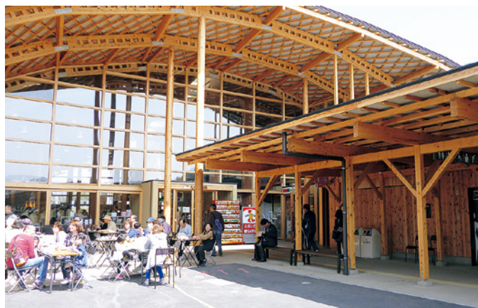
「もっくる新城」の正面入口
