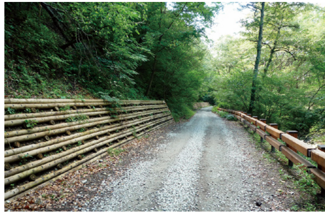
木製ガードレール等を設置した林道 (東信署)
