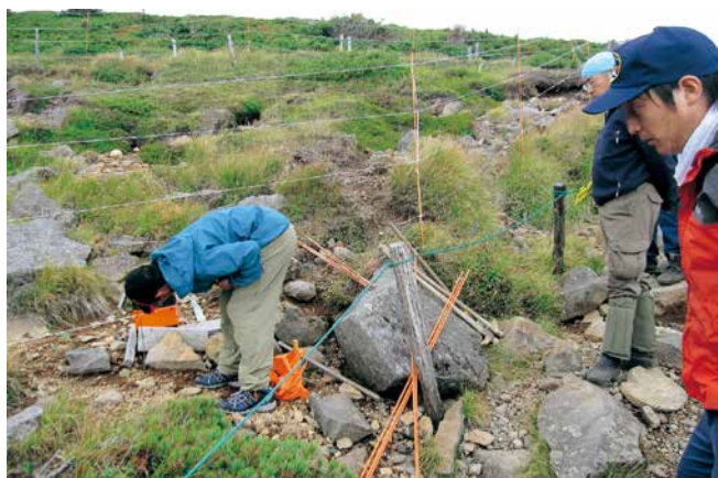
電気防鹿柵の設置
