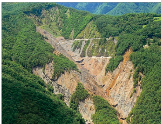
大鹿村小波川地区「鳶ヶ巣施工地」 (伊谷谷総合治山事業所)
