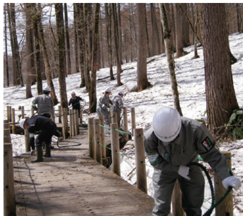
恒例となったグリーンロープ張り
