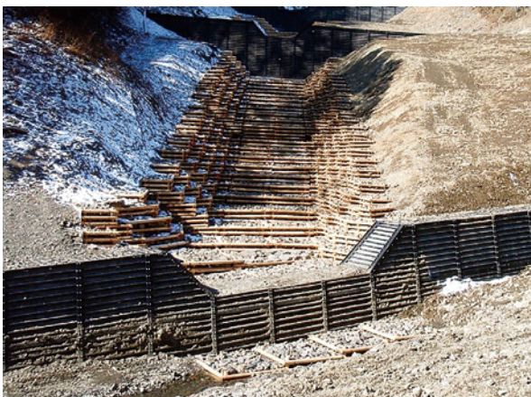
南信署の事例（瀬戸沢復旧治山工事）
