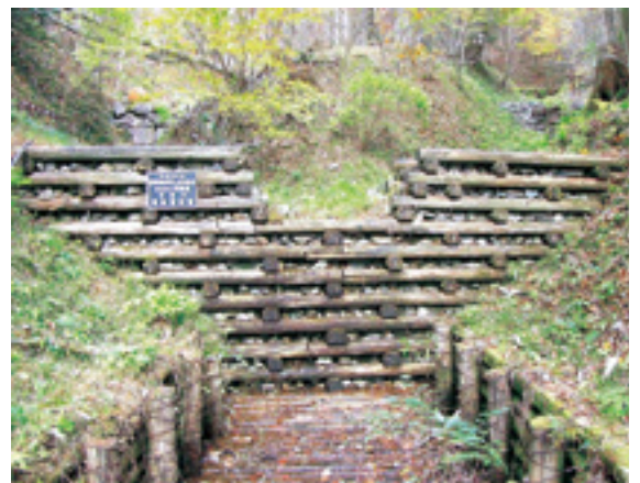
段戸裏谷：施工後9年経過
