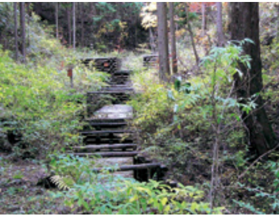
段戸弁天沢：施工後8年経過
