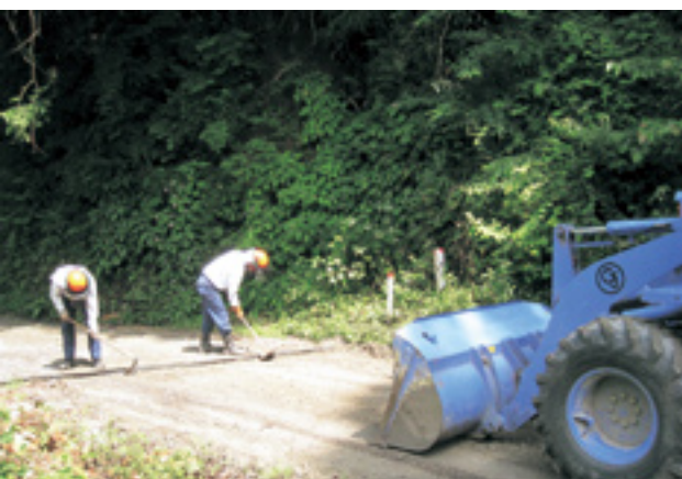
林道維持修繕を行う班員
