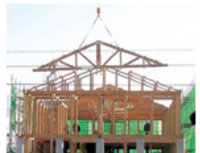
トラスをつり上げ
