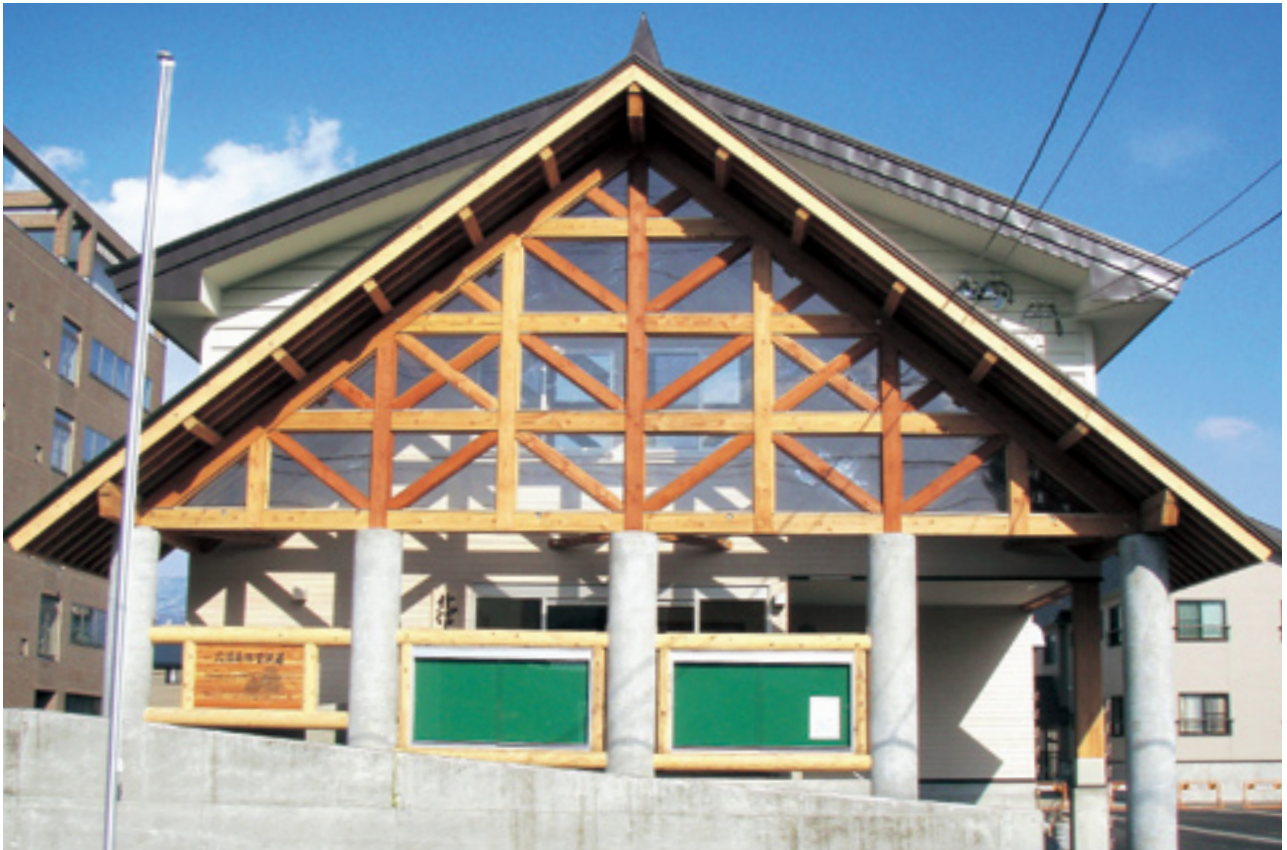
完成した北信署新庁舎
