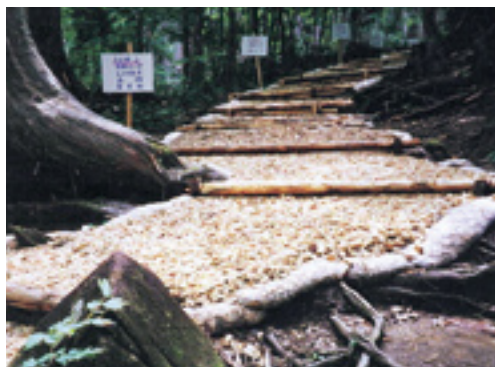
施工後の状況
