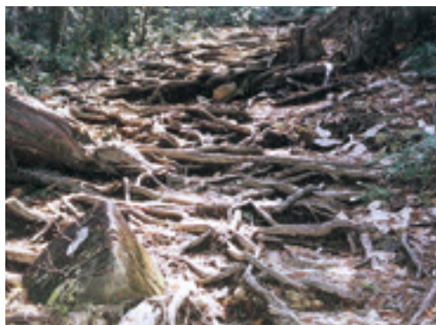
施工前の状況
