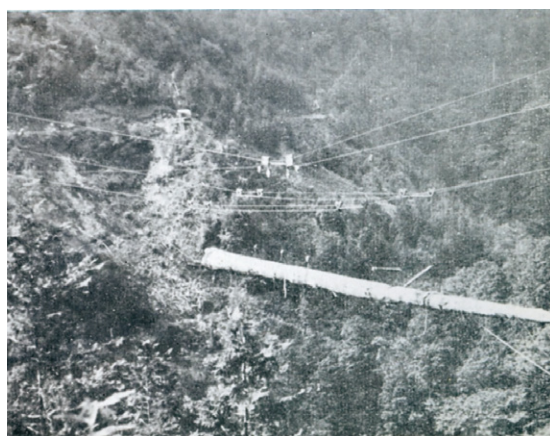
架線搬出中（広報「みどり」から）
