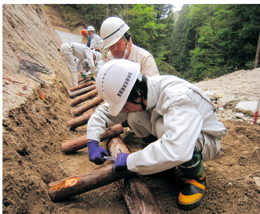
丸太筋工の施工を体験
