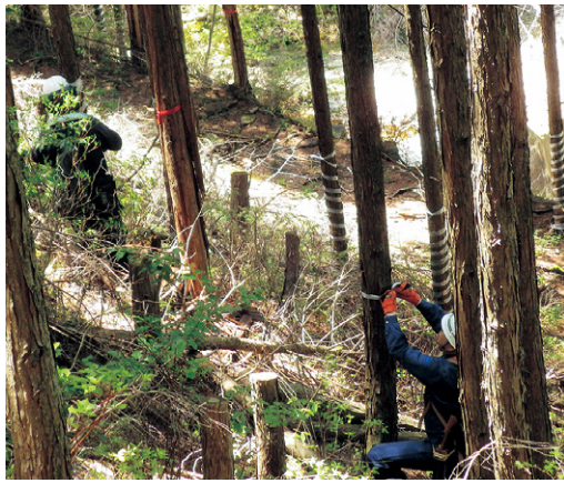
リンロンテープの施工
