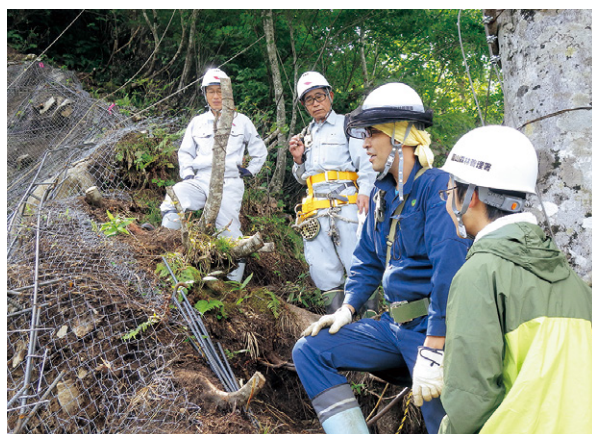
復旧治山工事現場視察
