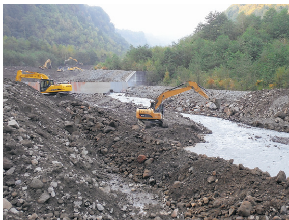
治山ダム上流部で進められる除石作業
