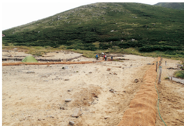
土留工(50m×2列)を施工
