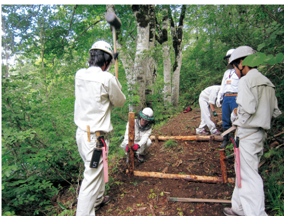
杭打ちを行う生徒たち
