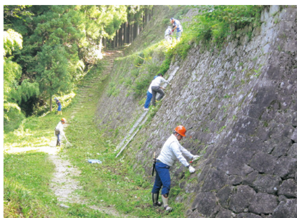
清掃作業の様子
