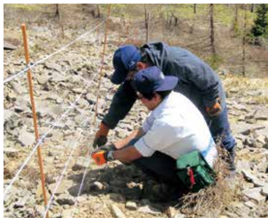
ニホンジカ対策の電気柵の設置
