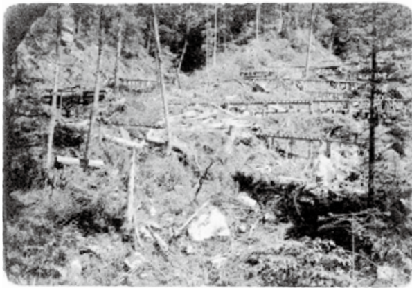
作業軌道の様子
