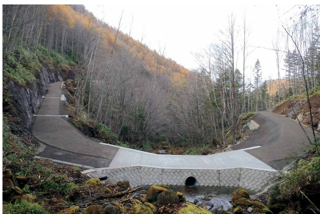
東俣谷林業専用道新設工事 完成状況
