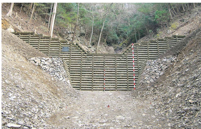
闇苅（男川支溪）復旧治山工事 完成状況
