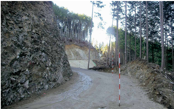
伊勢谷林業専用道新設工事 完成状況
