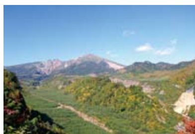
展望台より御嶽山を望む (土石流が流れ下った濁沢(左)及び伝上川(右)の復旧状況)
