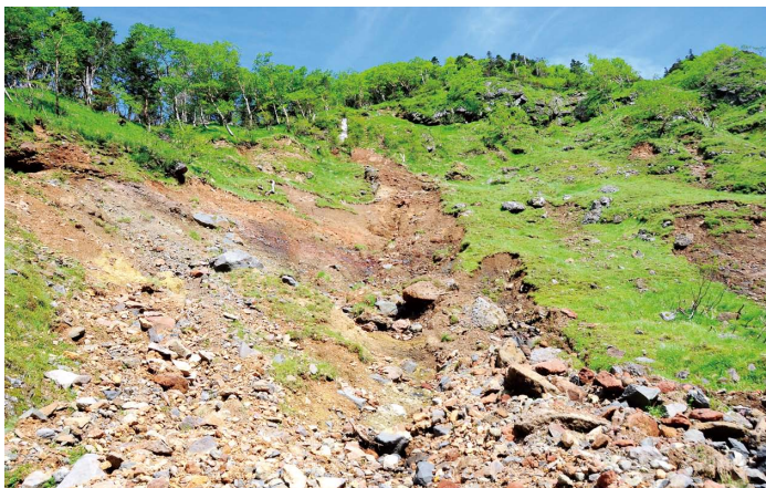
豪雨により崩壊した斜面（平成24年度）
