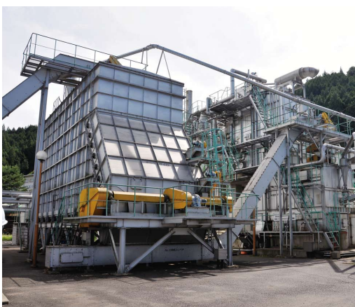
「森の発電所」のプラント
