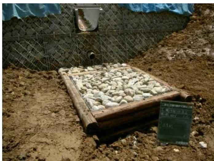
丸太水路工・鋼製枠土留工)
