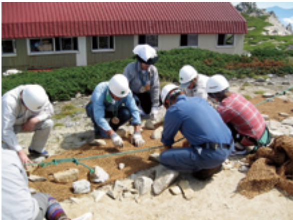
植生マットを敷設
