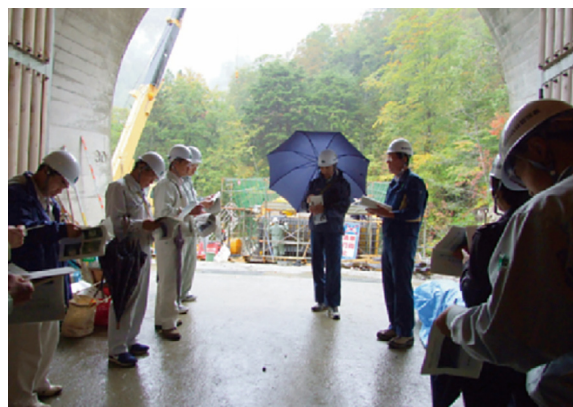
スゴ谷トンネル出口 （奥は橋梁新設工事箇所）
