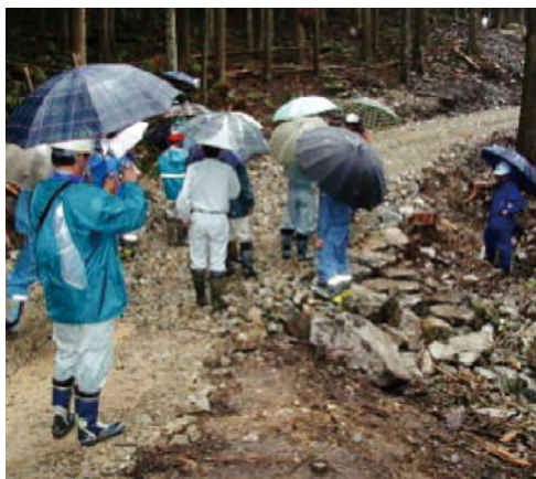
現地資材（転石）を活用した洗い越し
