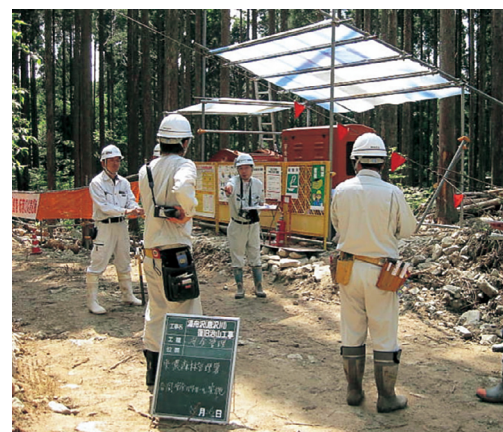
安全パトロールの様子
