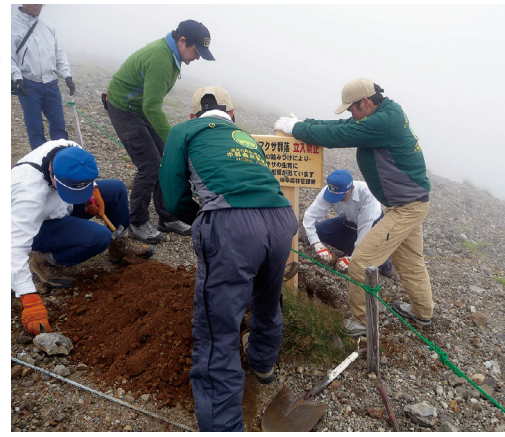
立入禁止看板を設置する関係者
