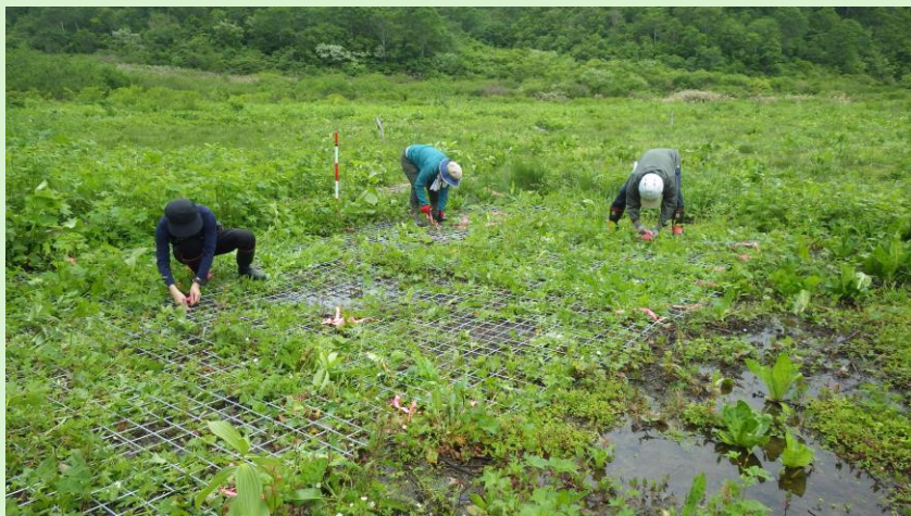
ワイヤーメッシュ敷設作業
