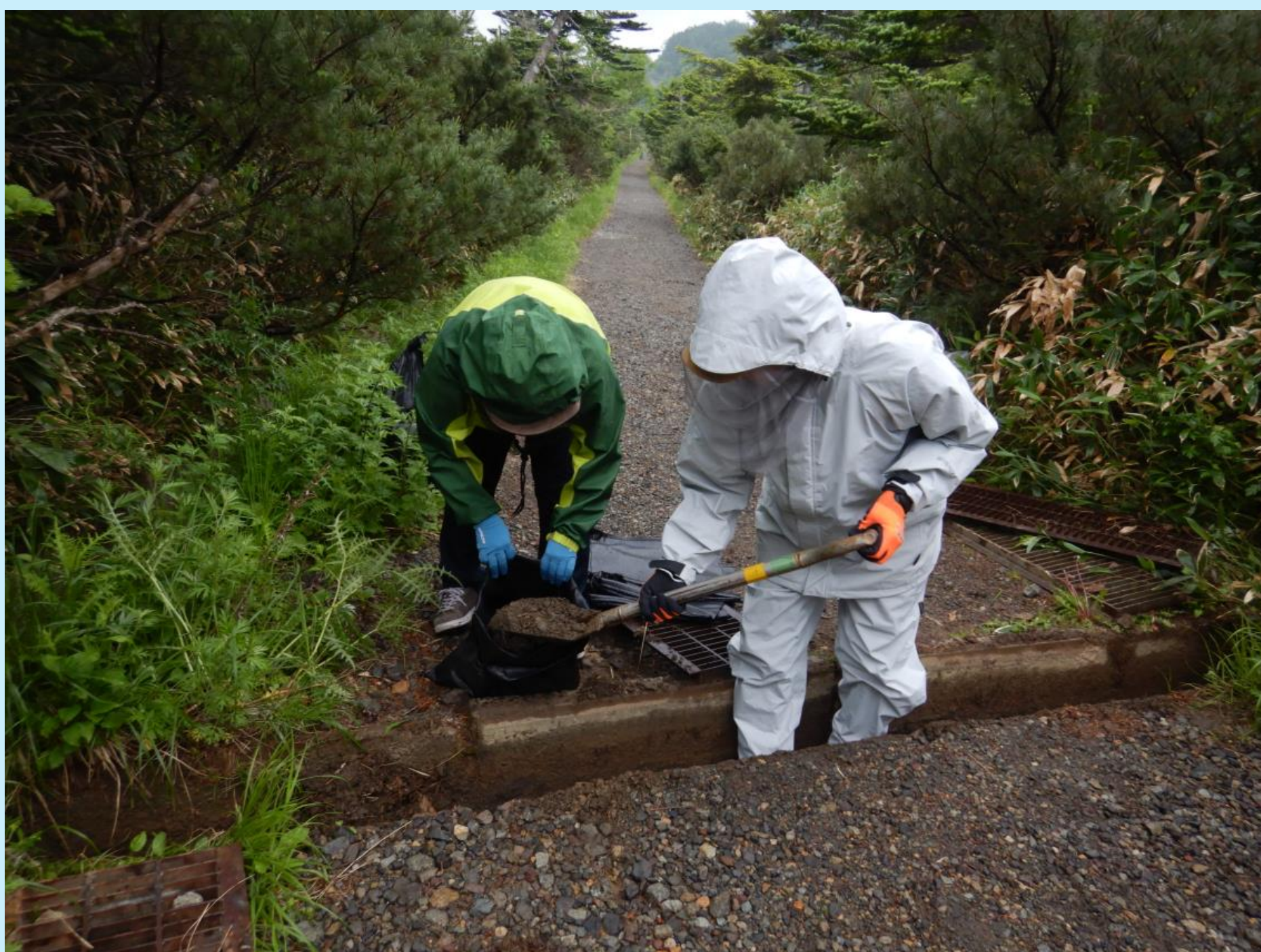
礼拝所付近での横断溝整備
