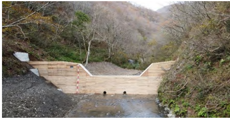
揖斐川流域、川上国有林内の谷止工
