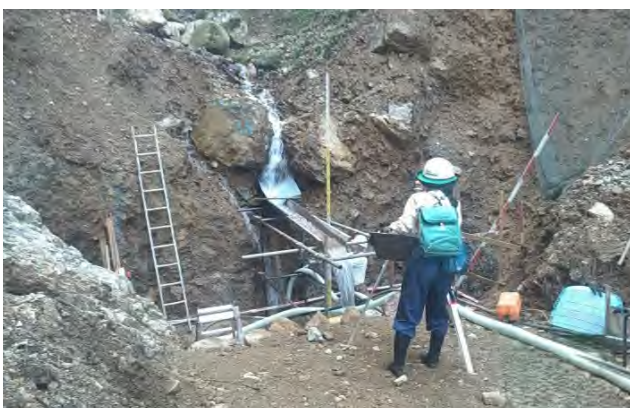
床掘検査(基準の高さまで掘削されているか確認)中の筆者
