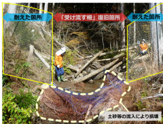
台風による被害の様子「受け流す柵」のみが損壊し、周辺の柵への被害は見られない(愛知所管内)
