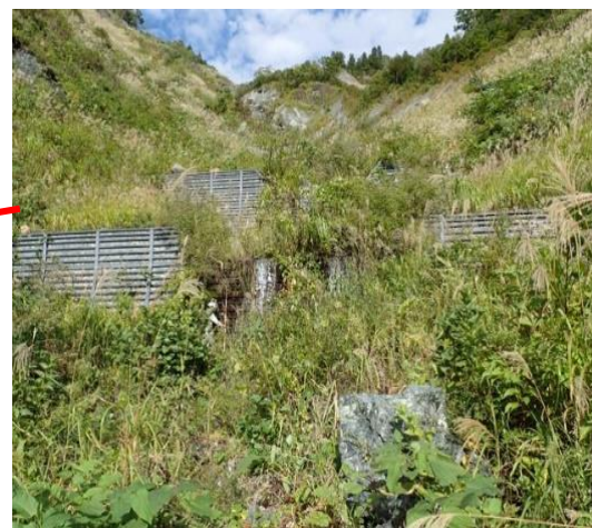
治山施設（谷止工）の設置により安定し緑化が進んだ渓流
