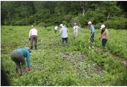
ワイヤーメッシュ敷設作業の様子
