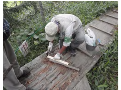
散策路の木道の補修(東信署)
