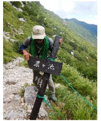
標識看板の修繕(南信署)
