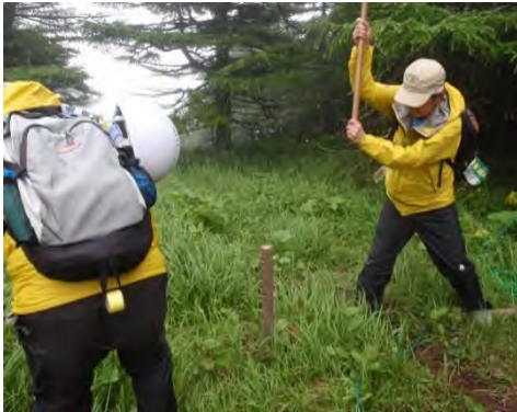
規制ロープ用の杭の交換(東信署)
