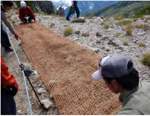
植生回復のためのマット敷設(南信署)
