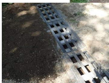
(写真下) 土砂が除去された横断溝
