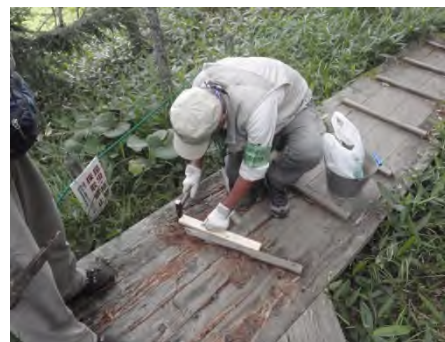
散策路の木道の補修(東信署)
