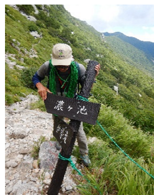
標識看板の修繕(南信署)
