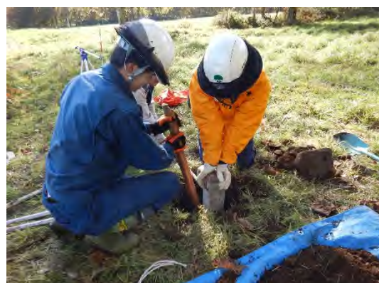
研修の様子：不明標解消(新たな境界標を設置)
