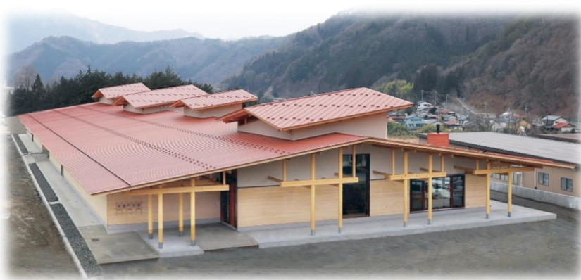
木曽町庁舎の全景 全長 108mの長大な平屋建て
