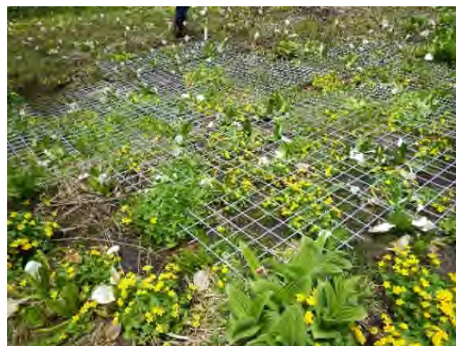
ワイヤーメッシュ敷設後の状況
