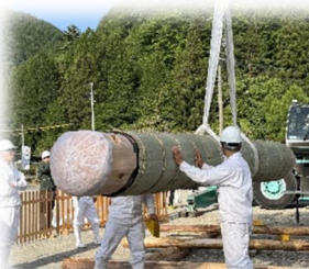
クレーンで吊り上げ(上) 積込完了!(下)
