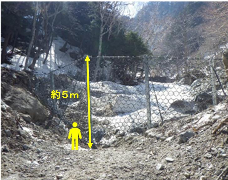
応急復旧対策として強靱ワイヤーネットを設置(上高地、地上高は約5m)
