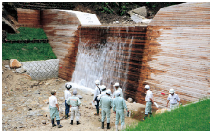
治山工事施工地の視察
