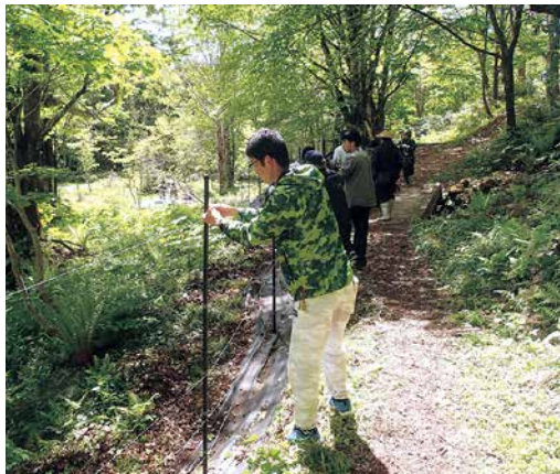
支柱へ電線を取付作業中
