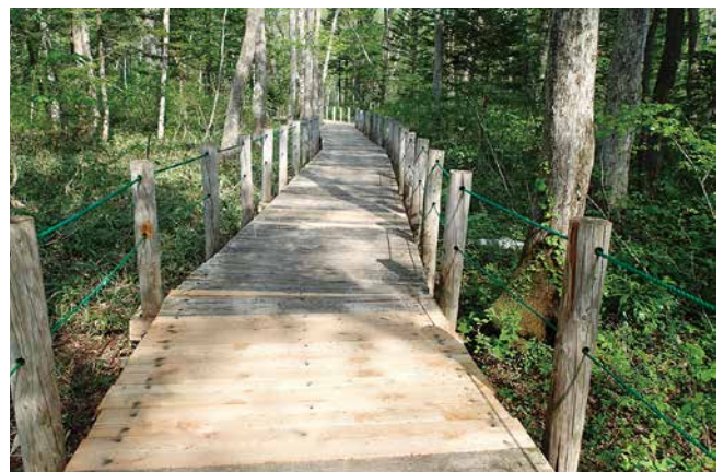
提供資材で補修されたバリアフリー歩道
