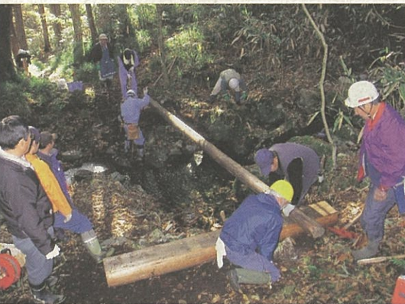
歩道橋の架け替え作業
