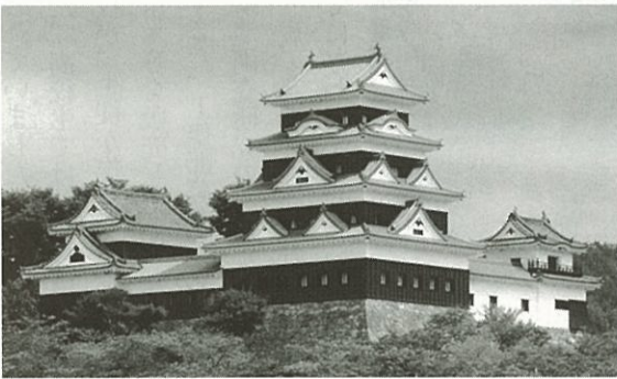
木曾ヒノキを使用し復元された大洲城（愛媛県大洲市）
