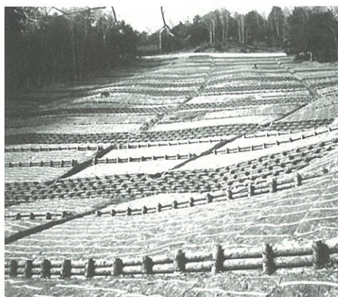
法面保護工の木材利用
