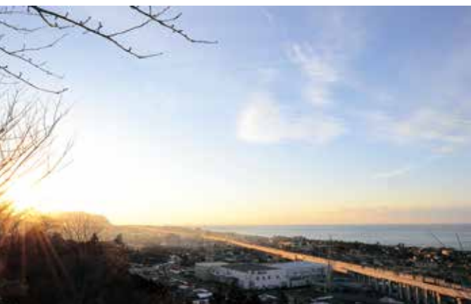
夕日に映える北陸新幹線高架橋
