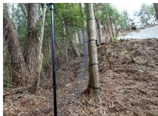
獣害防護柵の施工状況
