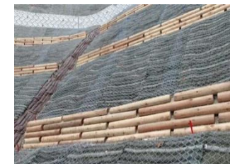
L型筋工の施工状況
