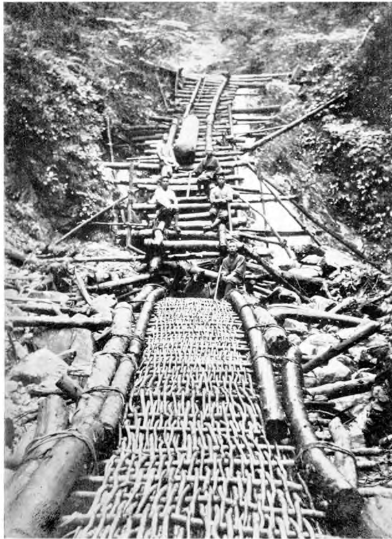
大正年代 たんばさで・そろばんさで搬出の景、貴重材はつり下げる
