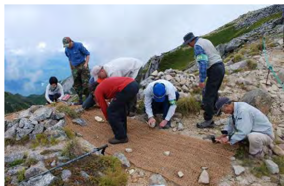
敷設箇所(敷設作業中)
