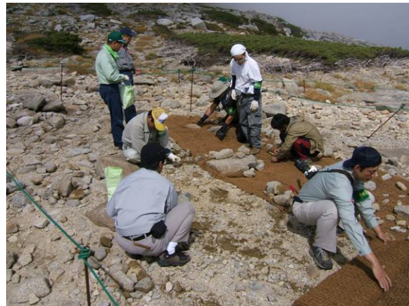
植生マットの敷設作業の様子
