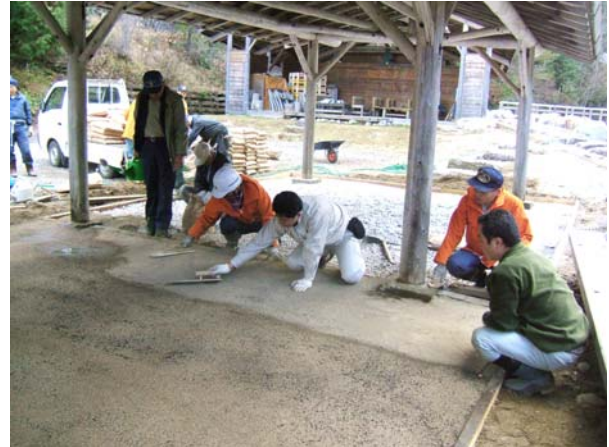
舗装材を平らにならす作業の様子
