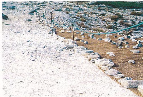
写真Ⅱ-27 マットの端部は礫による固定を図る
