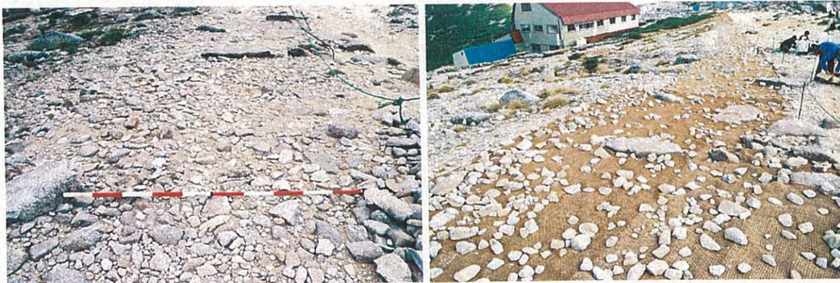
写真Ⅱ-21, 22 敷設前の基盤状況（左）と敷設後の状況（右）
