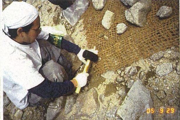
写真Ⅱ-25(左) マットの下にあった礫を再び、敷設したマットの上に載せている 写真Ⅱ-26(右) 釘とピン留めを利用して固定している
