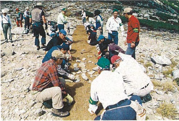
写真Ⅱ-25(左) マットの下にあった礫を再び、敷設したマットの上に載せている 写真Ⅱ-26(右) 釘とピン留めを利用して固定している
