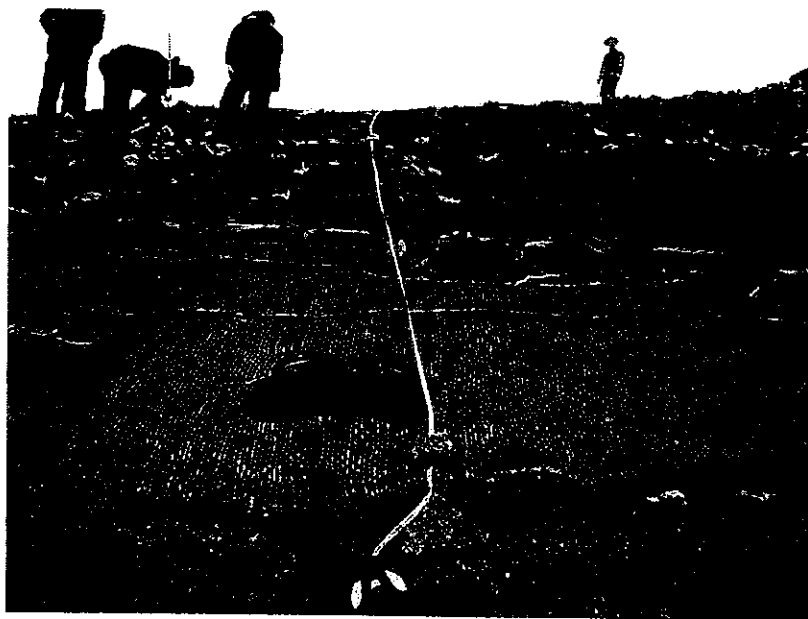
写真-3 復元施工地のセンターライン(巻尺の左右 1m が無播種区間)
