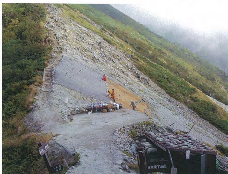
施工全景(東川岳方向から)
