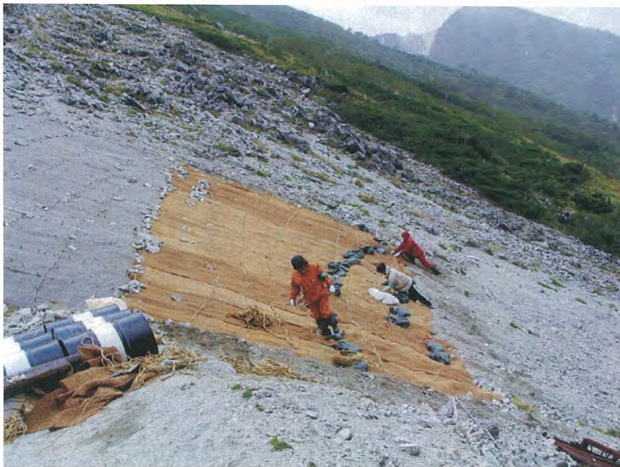
写真3-2 作業状況（麻むしろの固定）
