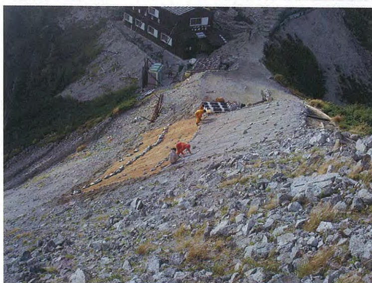
施工全景(空木岳方向から)
