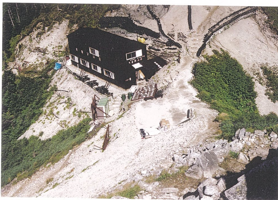
写真-1 写真上部の建物が木曾殿山荘、平地がヘリポート、右端が登山道、写真右半分の荒廃斜面が事業実施箇所。
