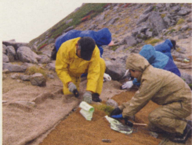
繊維マット敷設状況
