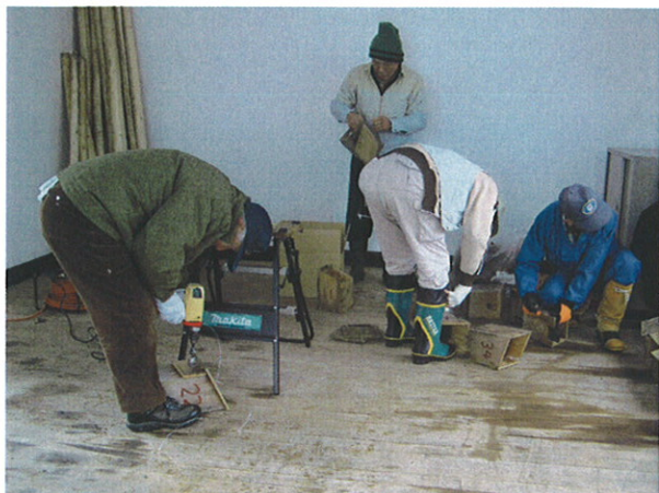
ネズミにかじられた入り口の修理
