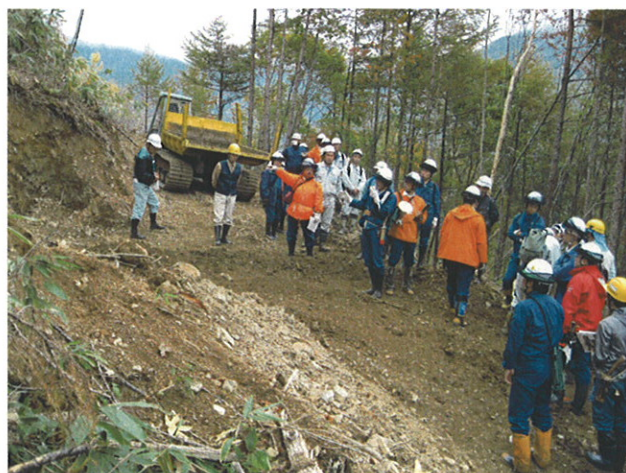
作業道の雨水処理にも配慮
