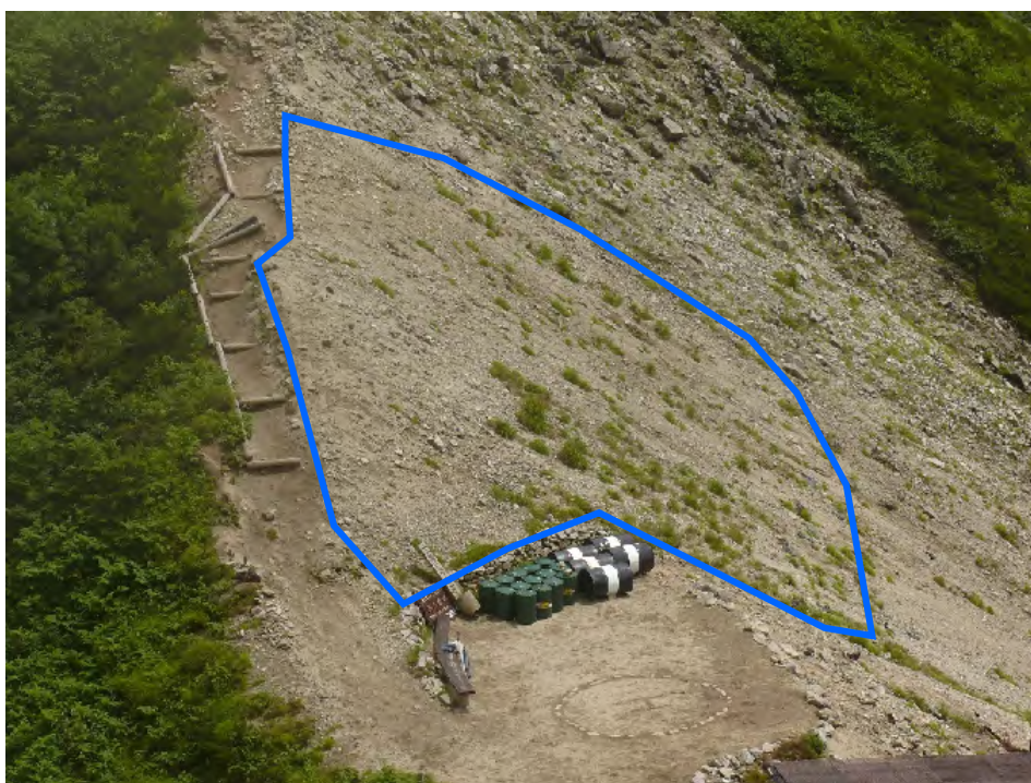
図 3.34 既設マット施工地（平成 15～16 年度設置）
