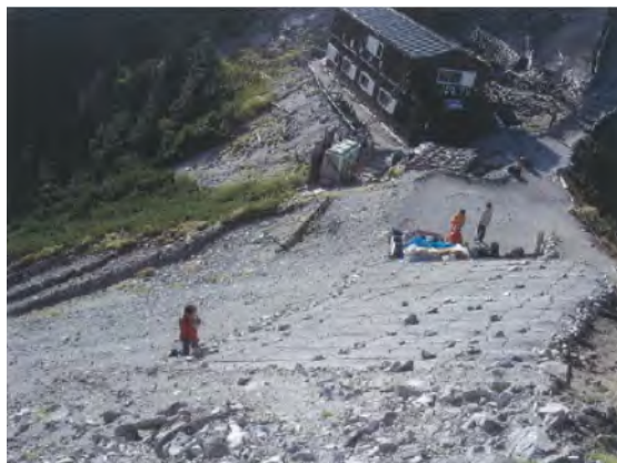
既設の植生マット施工地の様子
