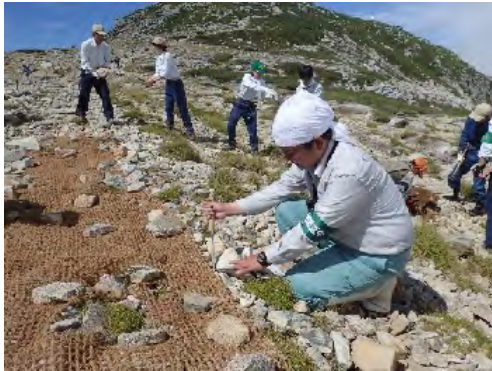
天狗荘南マット敷設風景
