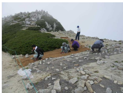
敷設作業（7月20日）
