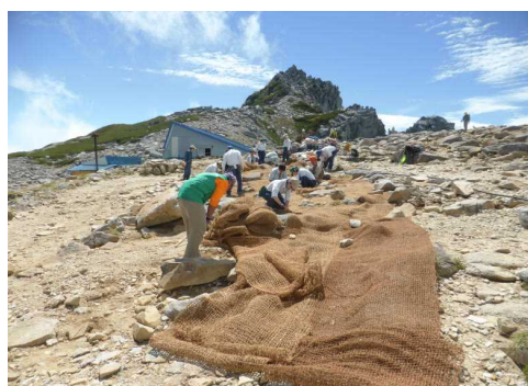
敷設作業（9月9日）
