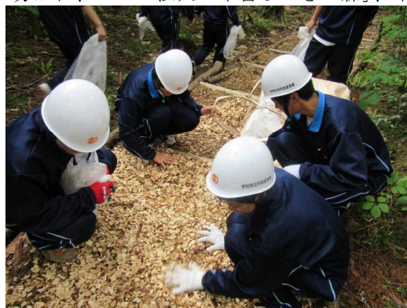
歩道へのチップ敷き作業
