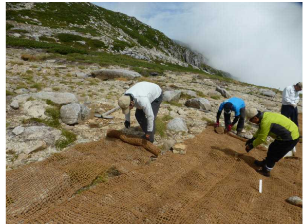
植生マット敷設2
