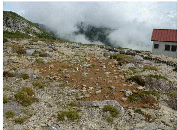
作業実施後の状況
